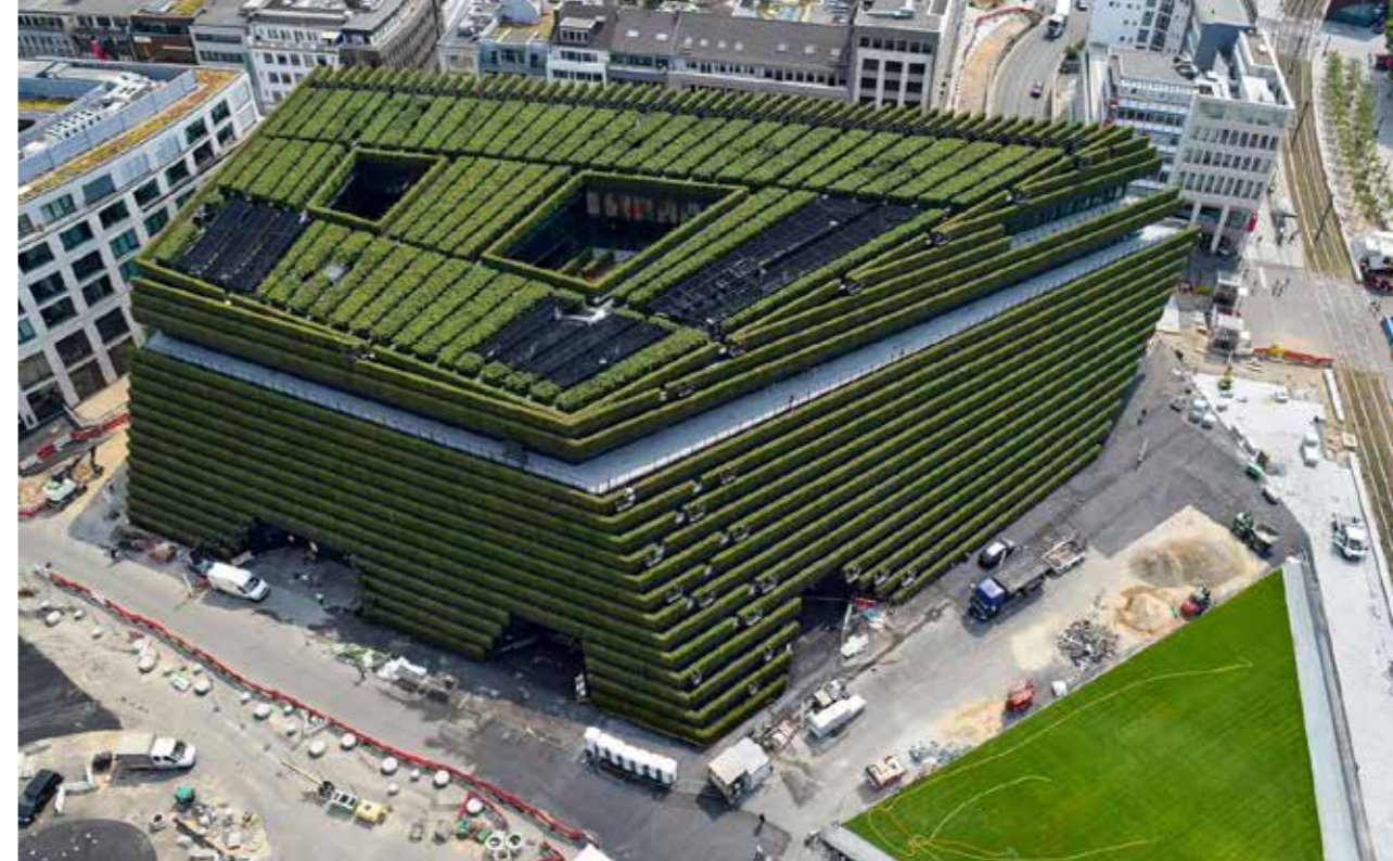
Komplettbegrünung eines Gebäudes mit Hainbuchen in Düsseldorf (Ingenhoven Architects).
